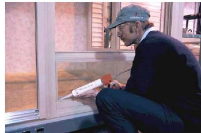
te al intemperismo, al envejecimiento, e inmersión en agua, soluciones alcalinas y detergentes. Resiste por corto tiempo a combustibles, aceites minerales, ácidos y álcalis diluidos. No requiere de primarios, se adhiere a toda superficie seca y limpia. Resiste movimientos hasta de un 50% del ancho de la junta original. Excelentes características de compresión/expansión.
