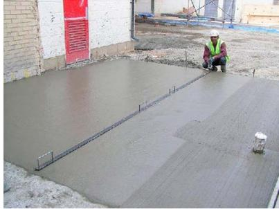
durante la colocación del piso de concreto sobre la superficie fresca, la cual ya haya sido nivelada y regleada.
