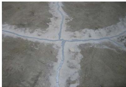
agregando arena sílica hasta formar una pasta antes de la aplicación del recubrimiento.
