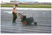
Sellador para juntas fisuras y caliente. Se emplea para el sellado de juntas en pisos de concreto, que deban resistir solventes tales como: gasolina, petróleo, gasavión, turbosina, aceites, grasas y derivados del petróleo.
